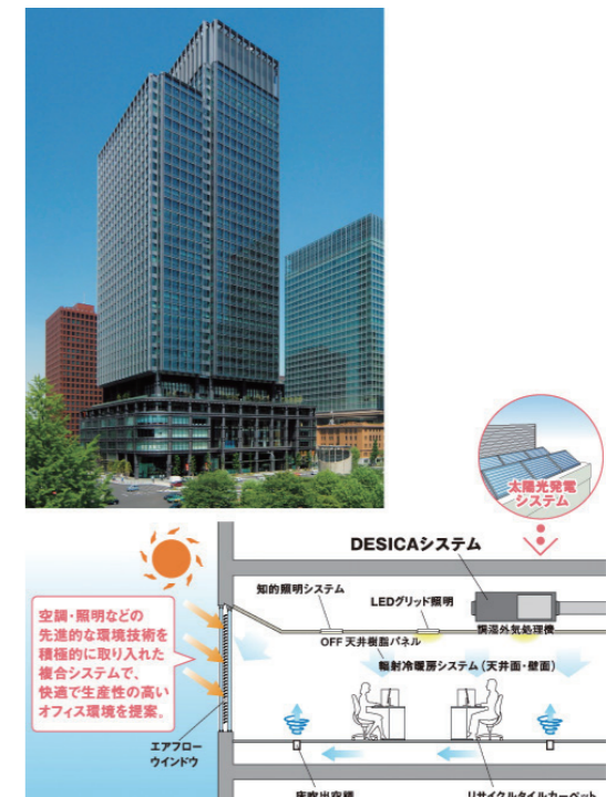
▲若手女性社員が営業に携わった湿度コントロールシステム ※エコツェリア(新丸の内ビル10階オフィス、施設面積:422.95m 2 (輻射空調面積:80m 2 )、採用機種:DESICA×1台)
